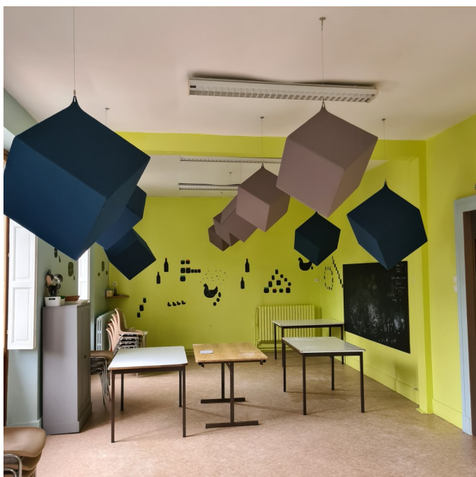
Pendant l'installation de l'isolation phonique
